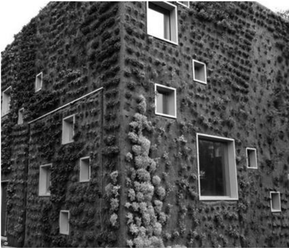
8. ábra. Épített-szerelt zöldfal, nem elég intenzív fenntartás eredményeként.
