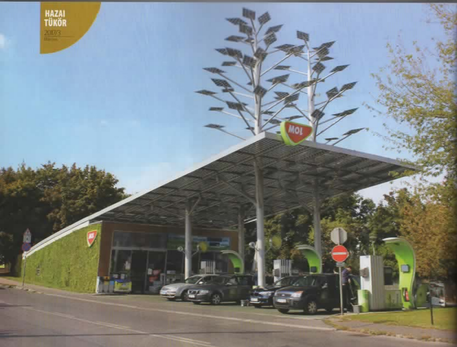
Budapest, Istvánhegyi úti Mol-benzinkút: az első zöld üzemanyag-töltő állomás Magyarországon, amelyre nemcsak zöldfalat, de zöldtetőt és napelemes rendszert is telepítettek
